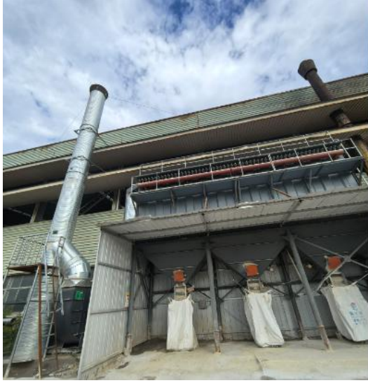
图3-22 脉冲+布袋除尘器
