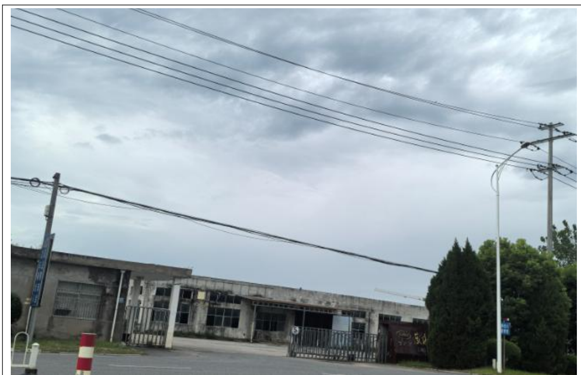
图3-10 安庆安达尔汽车制造有限公司空厂房现状
