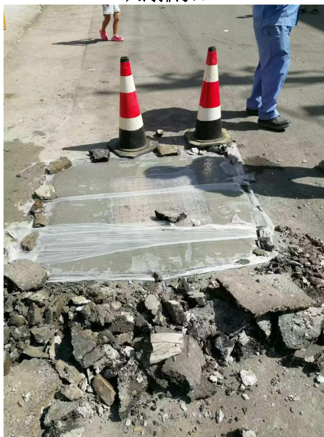
管网日常维护
