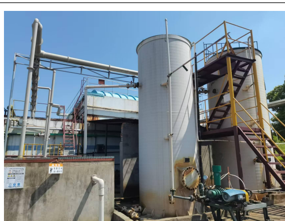
图 4.1-2 微电解+芬顿氧化
