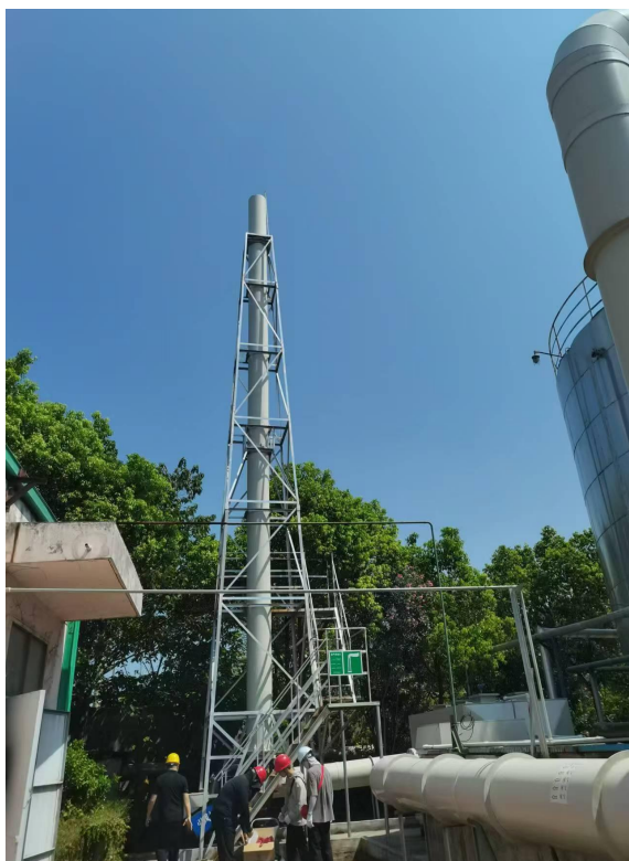
污水站及危废库废气排放口（4#排气筒）
