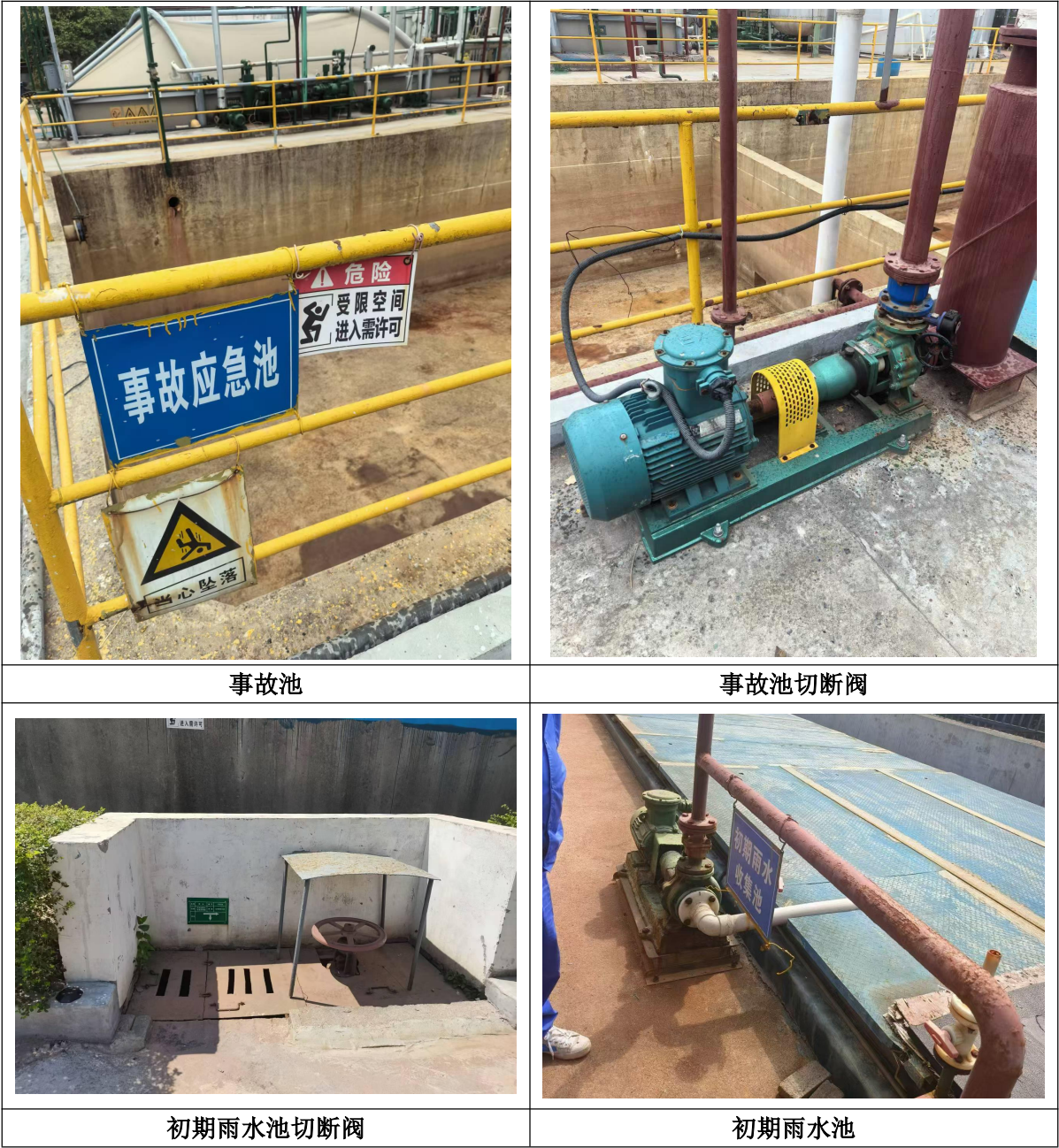
图 4.2-1 公司事故废水及雨水收集和排放系统图
