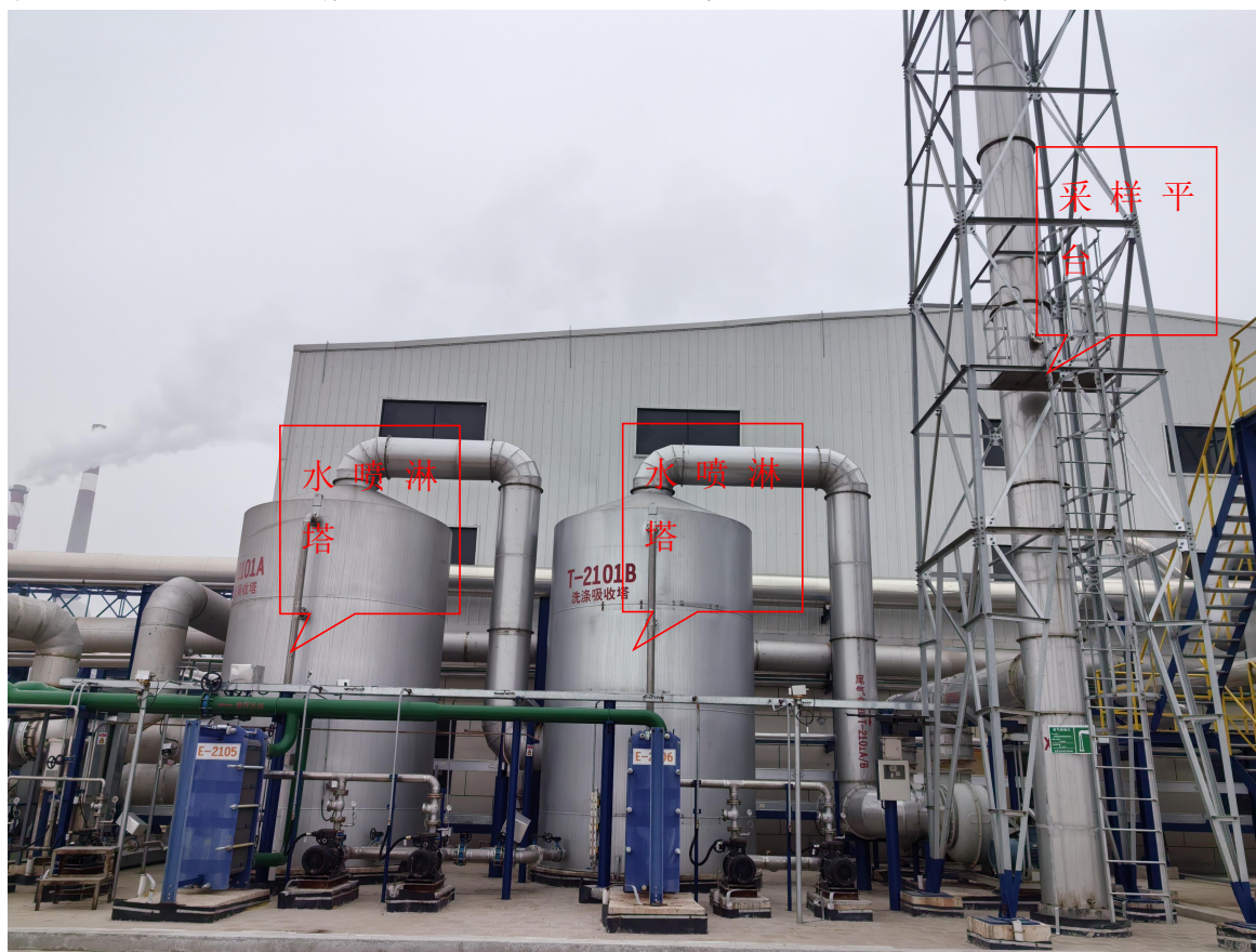
图 4.1-7 含氨废气处理措施
