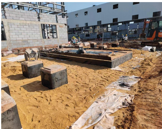
图 4.2-5 防渗施工照片
