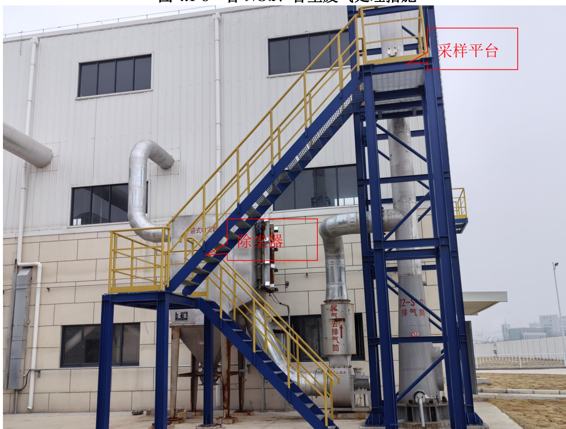
图 4.1-9 含尘废气处理措施
