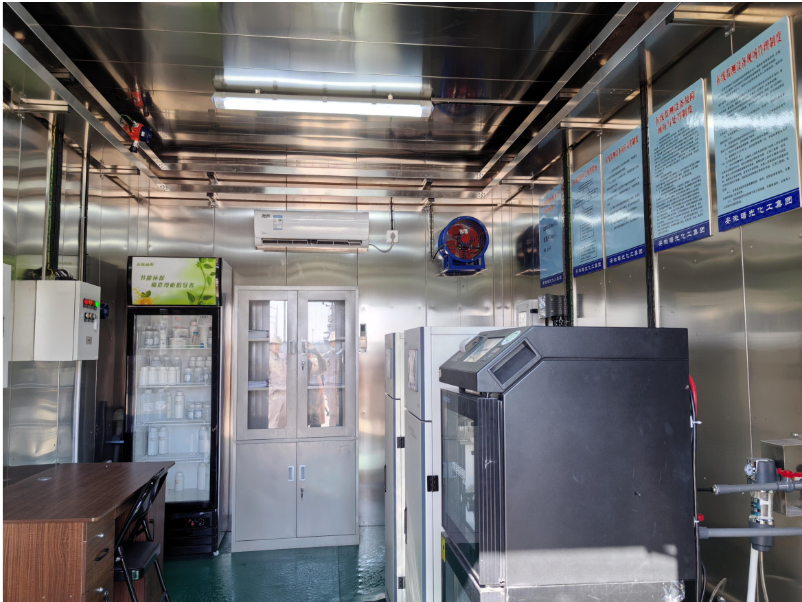
图 4.1-4 雨水在线监测设施
