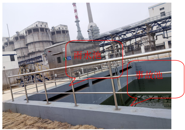
图 4.2-3 事故池、雨水池
