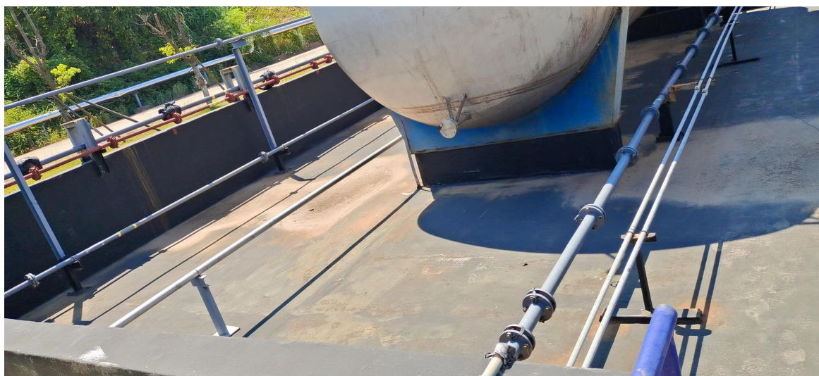
图 4.2-4 罐区围堰
