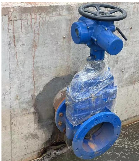
图 4.2-2 事故池切断阀图
