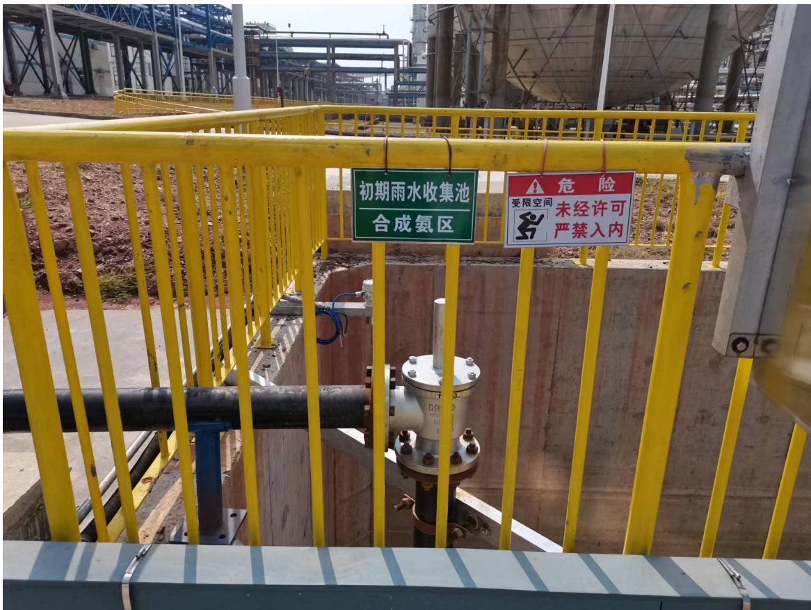
图 4.2-2 初期雨水切换阀
