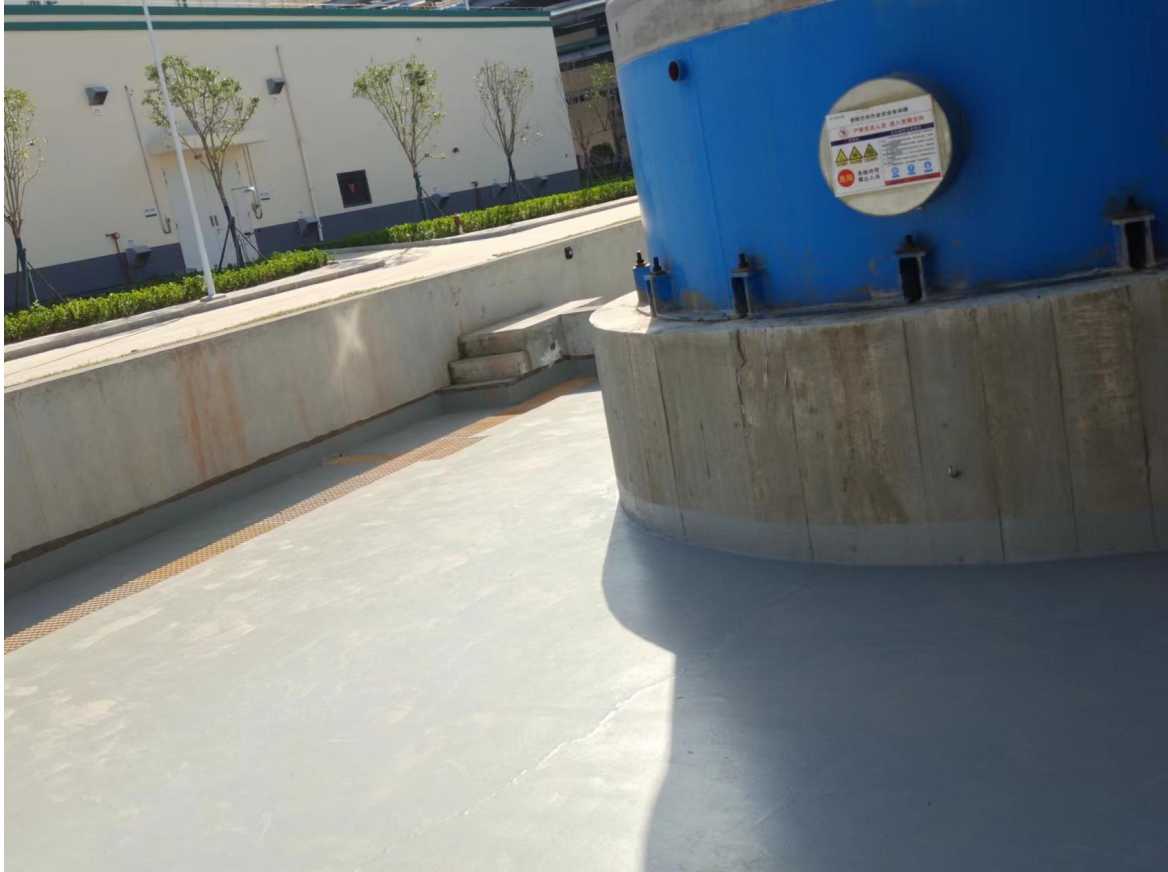
图 4.2-3 罐区防渗及围堰
