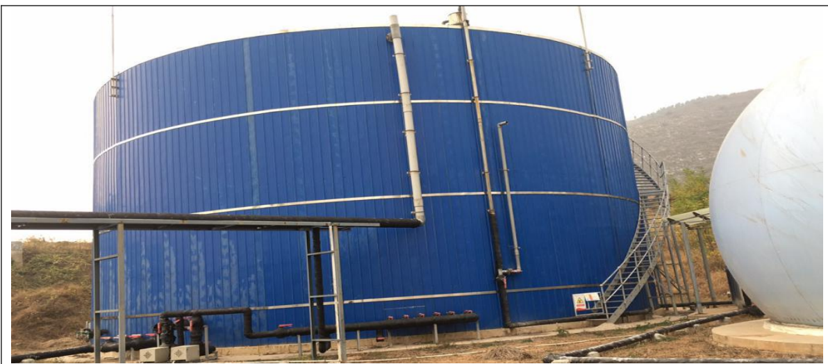
污水处理站 UASB 发酵罐
