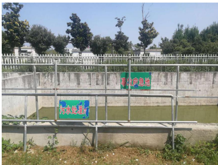
图 6-6 污水池、事故池
