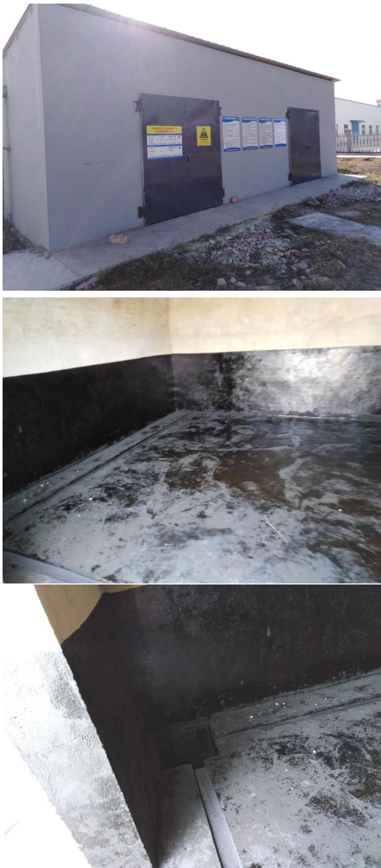
图 6-9 危废暂存间照片
