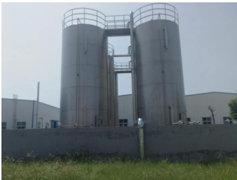
图 6-1 储罐区围堰
